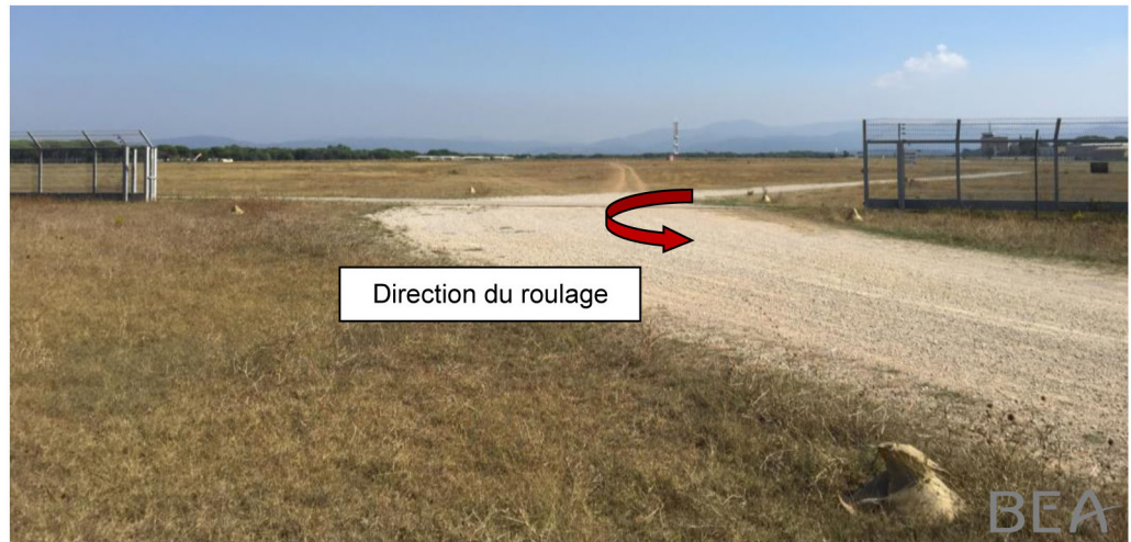
Voie de circulation « k » et portail
